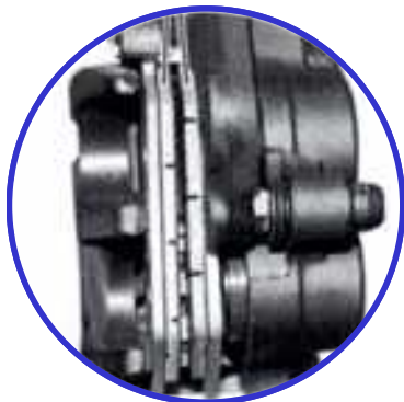
Sichtkontrolle der Indikatorkerben bei hydraulischer Scheibenbremse
